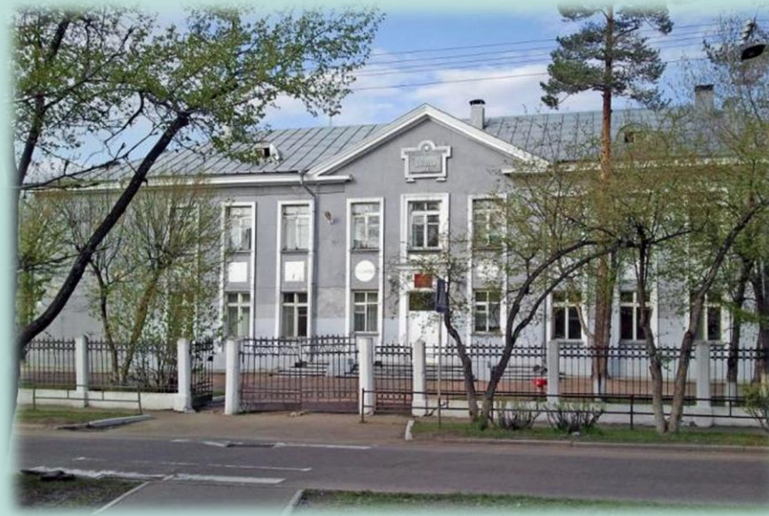
Здание 2 – ул. Московская, 10
